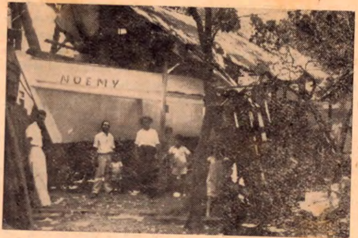
LANCHA NOEMI en construcción. — Quilla 30 pies; Eslora 44 pies; Manga 11 pies; Puntal 4½ pies. — Botada al agua en 1948.
